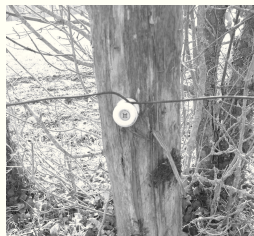
Un poteau en bois avec isolateur en porcelaine.
