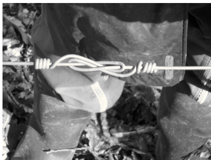
Ce nœud permet aux deux parties de fil d'être bien en contact.
